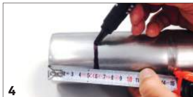
Marcatura quota d'innesto / Marking the insertion's depth
